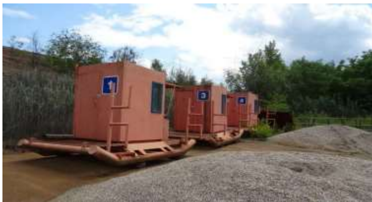
Камеры выемки сточных вод
