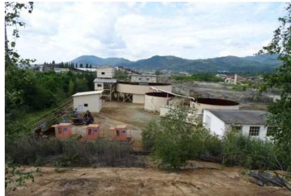
Блок приёма отходов: система сгустителя на Центральной плотине
