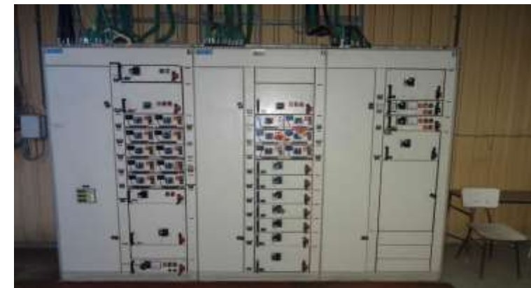
Электронный модуль блока управления и наблюдения
