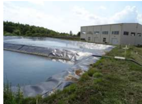
Бассейны очистки воды, водоочистная станция
