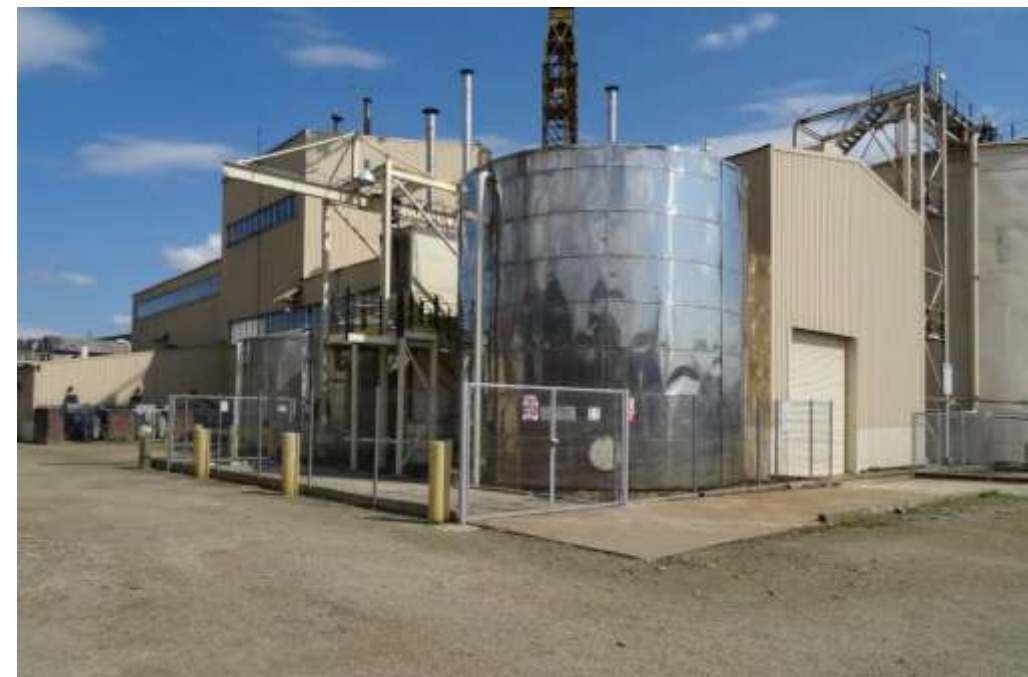
Завод Romaltyn — вид на северо-западную сторону
